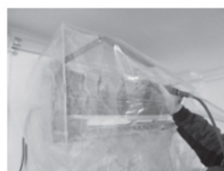
施工作业 洗浄・リンス
