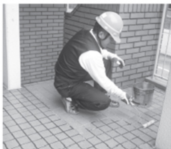
屋外の現場にて刷毛ローラーでスキッドガード施工中
